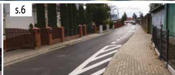
Ulica Karwacjanów po remoncie
